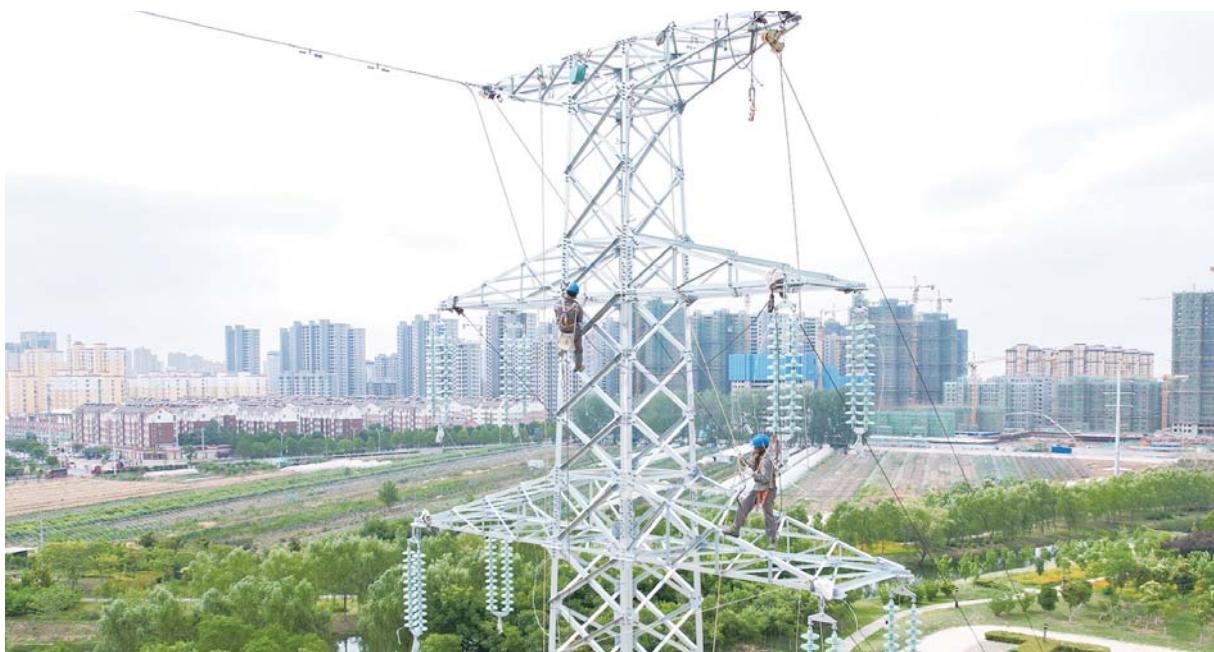
电力人员在进行高空作业。
