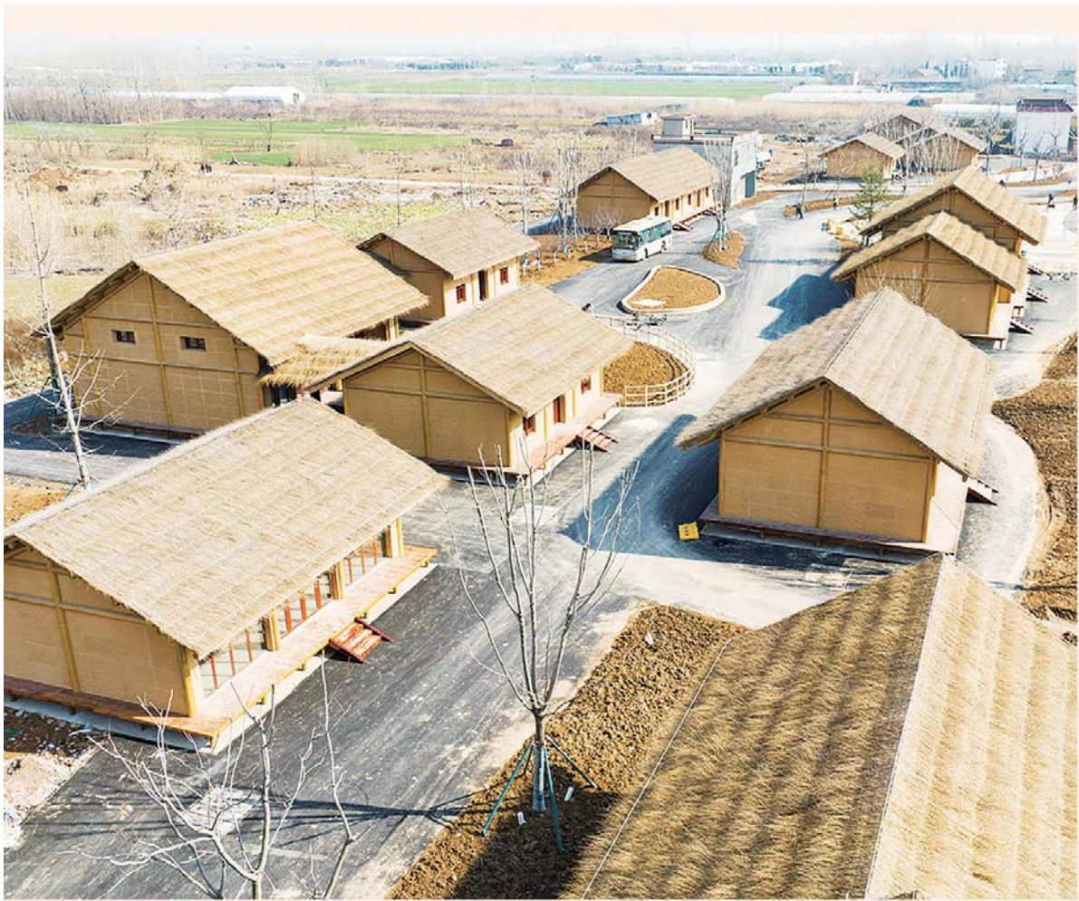
双墩文化村干栏式茅草屋完成主体施工。
