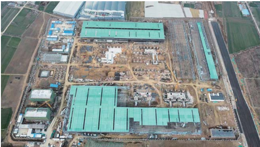
鸟瞰五河县新能源电池集流体材料项目施工现场。李向前 摄
