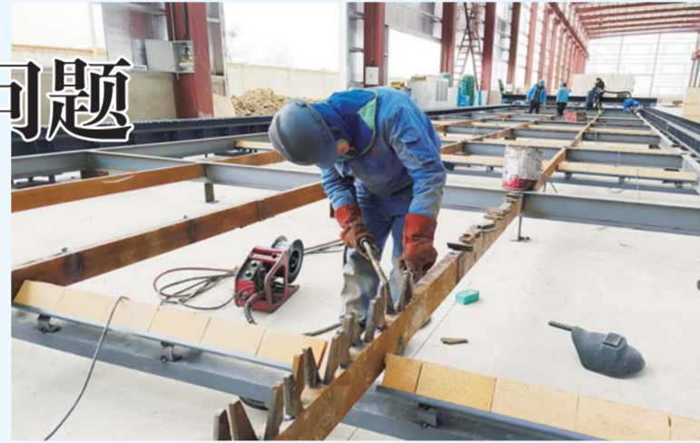
永固钢结构员工加工钢箱梁。
