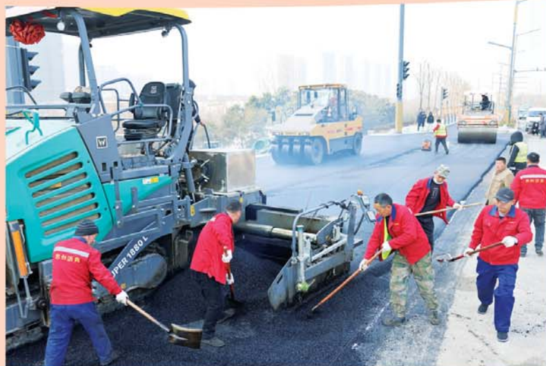
2月1日，滨河南路二期道路正在铺设沥青，现场热火朝天。
