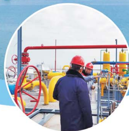
开展燃气安全隐患排查。
