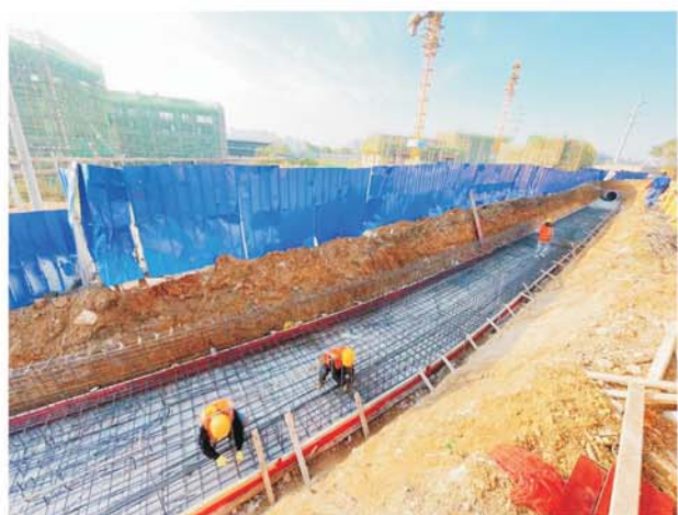
排涝工程加紧施工。
