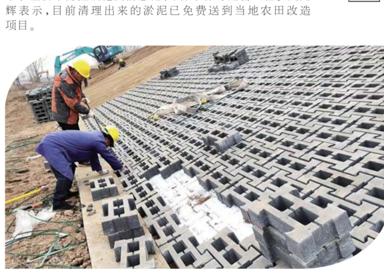
工人对沿河护坡铺设预制砖块。
