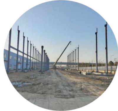
旺旅项目建设现场。
