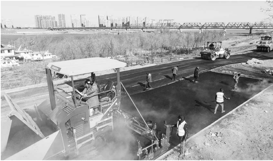
工人们正在铺设沥青
