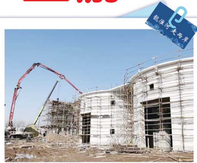
湖贝新材料绿色循环项目施工现场。
