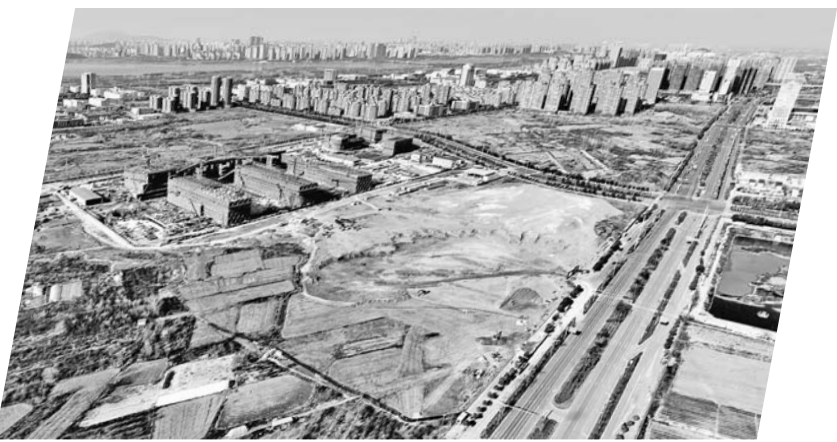
项目现场航拍。
