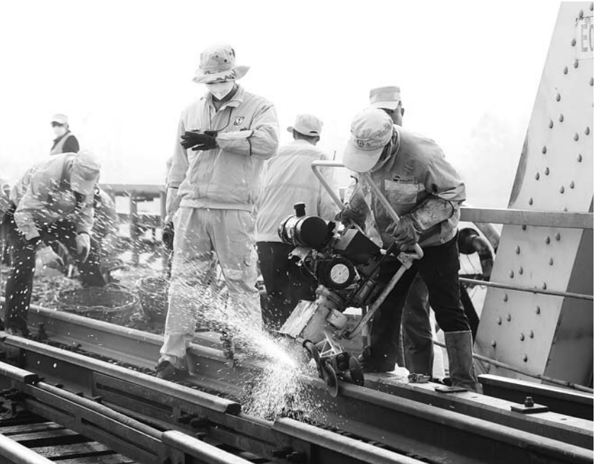
维修人员对钢轨焊接处进行打磨。
