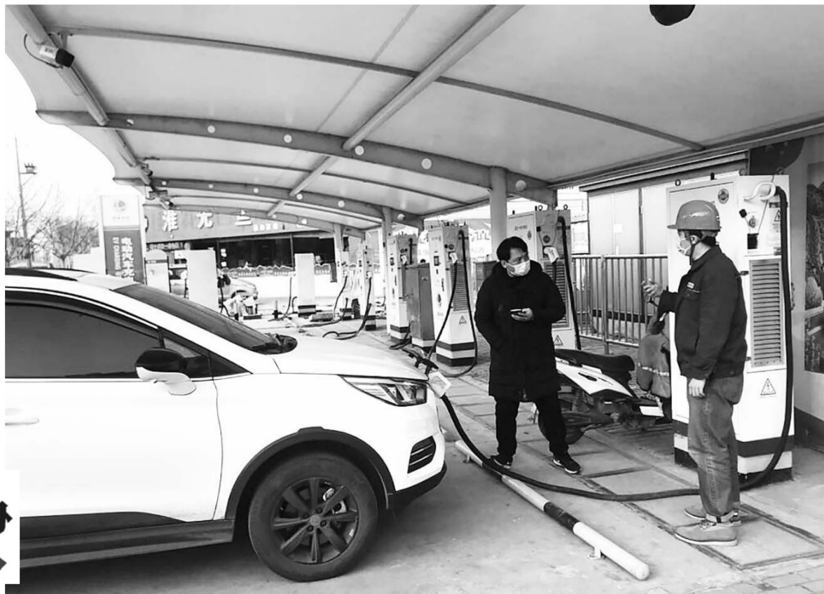
国网蚌埠供电公司工作人员在淮上区朝阳北路充电站指导用户进行充电。
