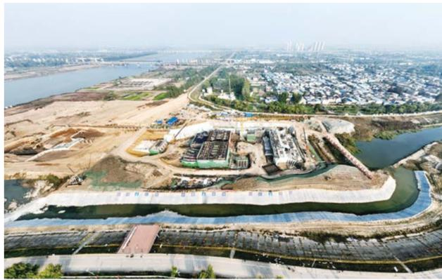
作为“观淮河”重点工程之一,龙子河口综合枢纽布置工程将新建龙子河口封闭堤防540米,移址新建龙子湖网站工程。
