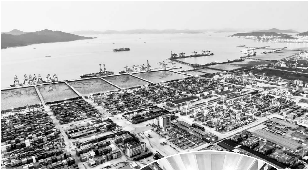
▲宁波舟山港北仑港区集装箱码头。
