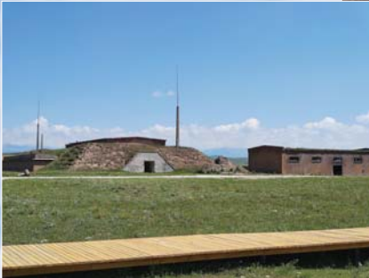
▲二分厂内一个生产车间旧址。
