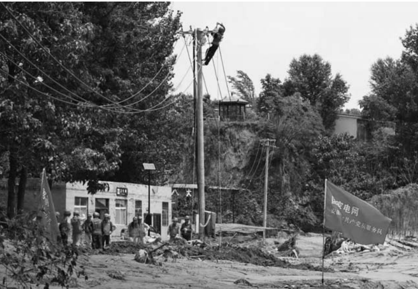
援豫抢修人员正在进行拉线、紧线作业。钱颀 摄
